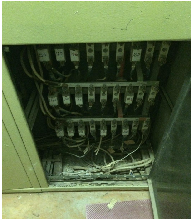
Рисунок 15. Учебное здание №7, ВРУ-1, РП-4 (состояние удовлетворительное)
