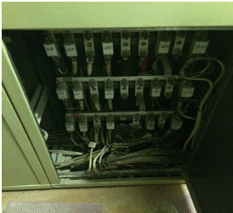
Рисунок 13. Учебное здание №7, ВРУ-1, РП-3 (состояние удовлетворительное)
