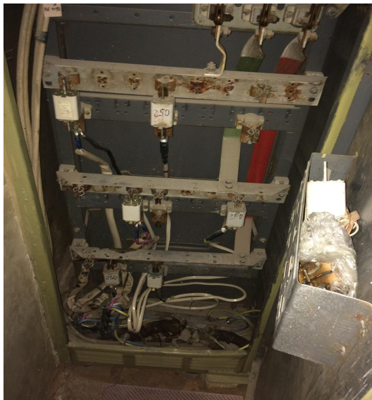
Рисунок 11. Учебное здание №7, ВРУ-1, РП-1 (состояние удовлетворительное)
