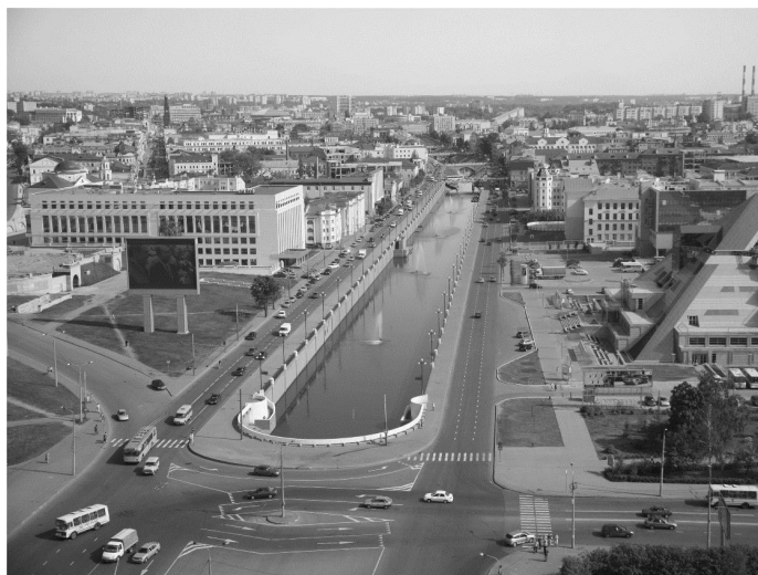
Сейчас Булак изменился очень «круто» (стал с бетонными крутыми берегами)
