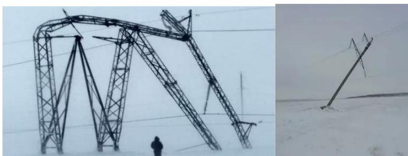
Рисунок 1 - Разрушение опор (07.04.2020, Костанайская область, Казахстан)
