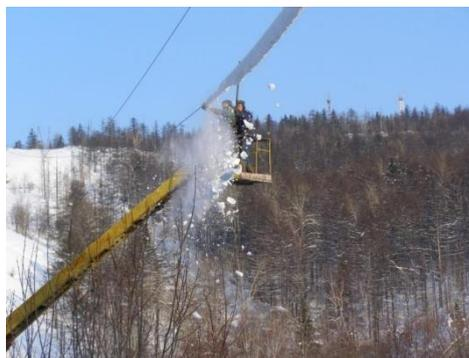
Рисунок 2 – Механический способ удаления гололеда
