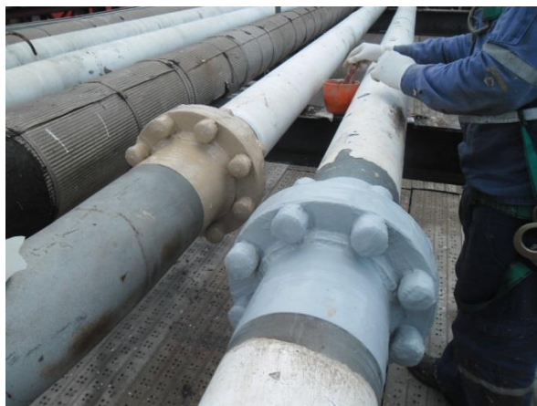
Рисунок 3 – Нанесение полимерного покрытия
