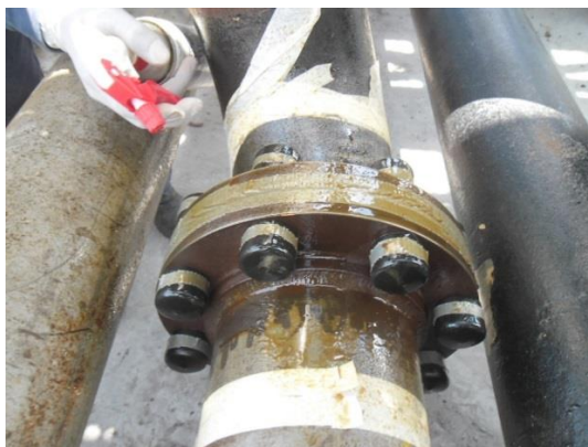
Рисунок 2 – Нанесение ингибитора коррозии
